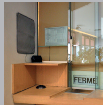
✓ « Tapis » boucle à induction miniature
