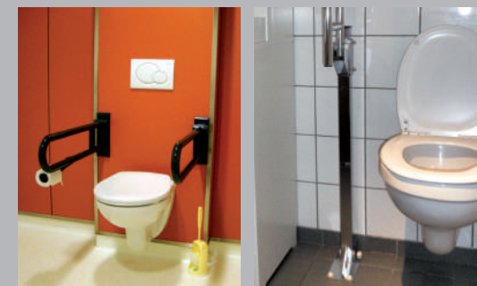
✗ Sabot de fixation dans la zone de transfert
