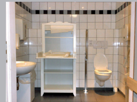
✗ Aire de transfert encombrée par table à langer et n'étant pas dans l'axe de la porte
