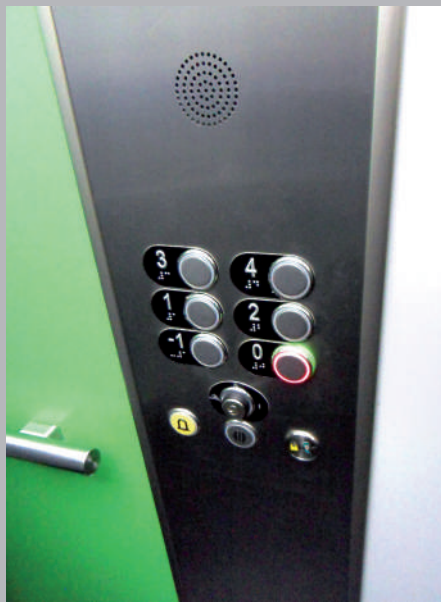
✓ Boutons de bonne taille, en relief et traduits en braille
