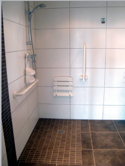
✓ Aire de transfert libre de tout obstacle
