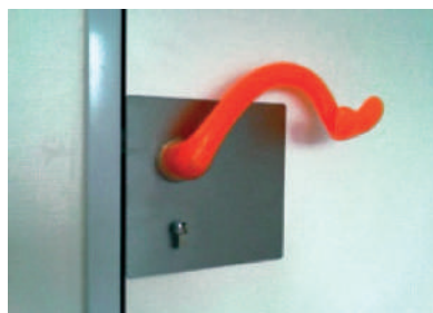
✓ Poignée contrastée et actionnable poing fermé
