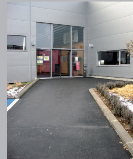
✓ Voie d'accès de largeur suffisante.
