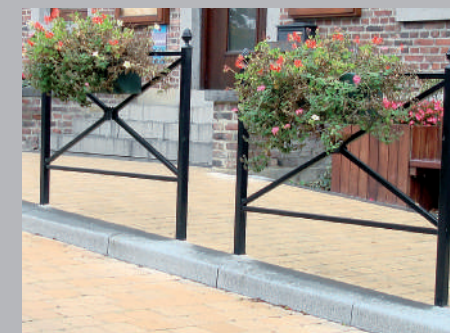
✔ Barrière contrastée et hauteur conforme
