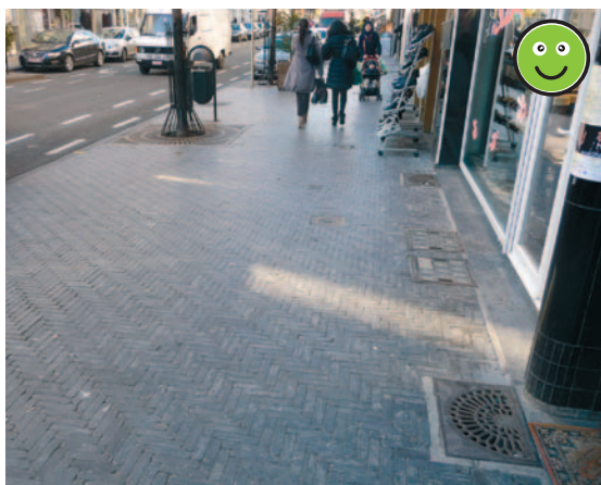
Grilles et couvercles disposés le plus possible hors de la zone circulée
