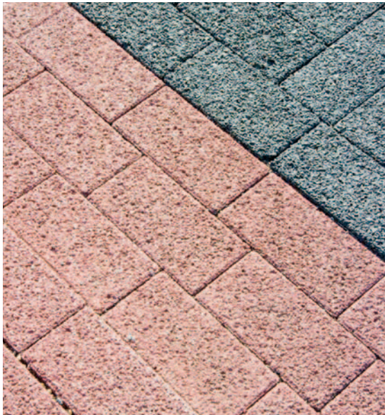
Revêtement drainant en pavés de béton poreux
