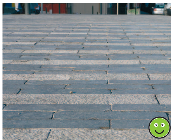
Revêtement en pierre bleue présentant une bonne planéité
