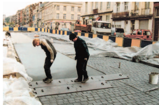
Revêtement en béton imprimé en cours de réalisation
