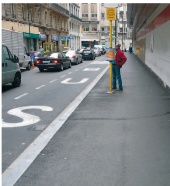
Revêtement bitumineux (enrobé à chaud) utilisé dans le centre de Bruxelles
