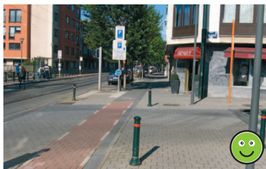
Trottoir traversant conforme (niveau constant et même coloration)
