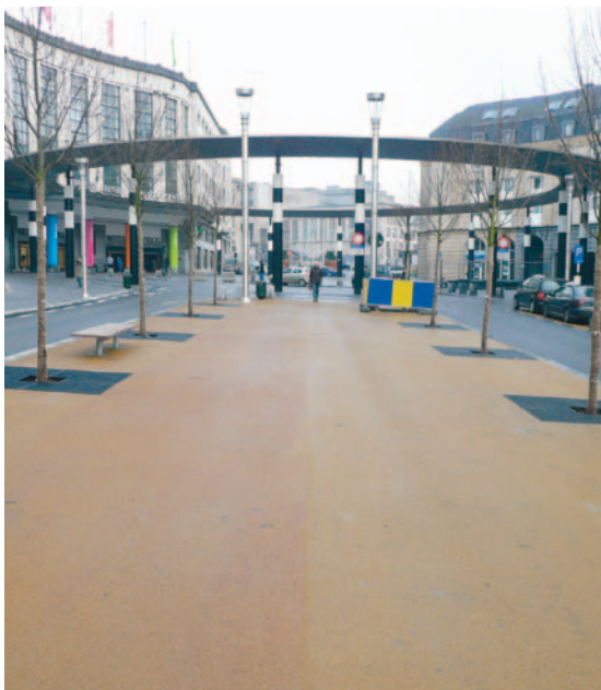
Zone piétonne à Bruxelles réalisée en revêtement bitumineux type enrobé à chaud
