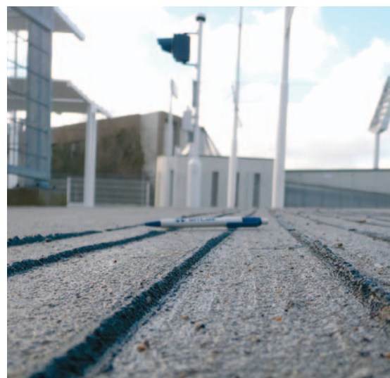
Plots d'éveil à la vigilance en inox accompagnés de barrettes en époxy
