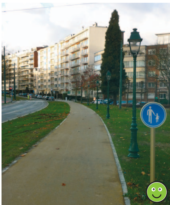
Revêtement piéton bitumineux coloré
