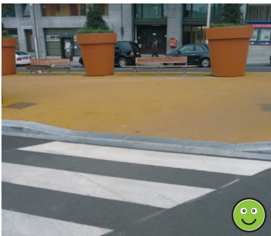
Jonction chaussée-cheminement piéton accessible
