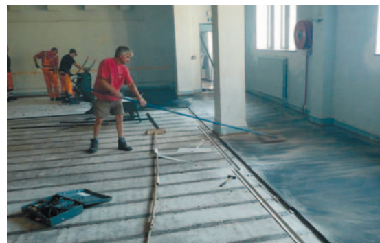
Nivellement de l'asphalte coulé à l'aide d'une spatule
