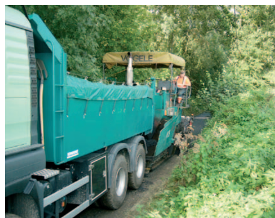
Mise en œuvre en faible largeur
