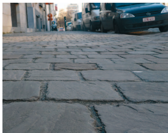
Revêtement de trottoir en pavés de pierre naturelle (format pavés platines)
