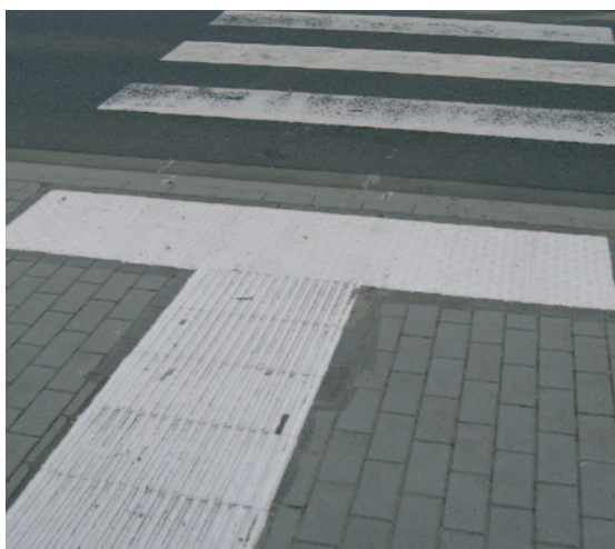
Revêtements podotactiles thermocollés
