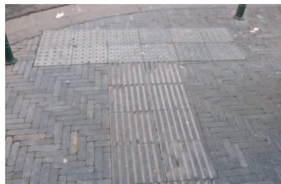
Revêtements podotactiles en pierre bleue
