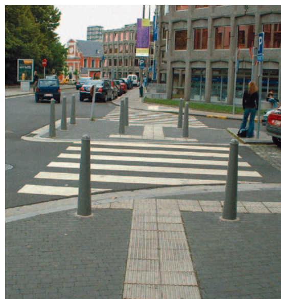
Revêtements podotactiles en béton indiquant une traversée piétonne
