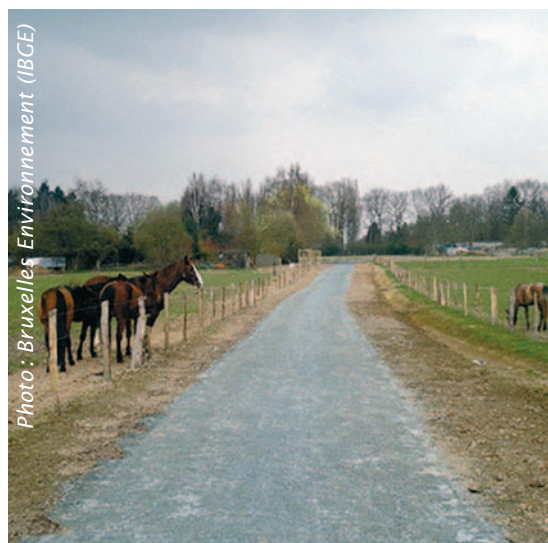
Revêtement non stabilisé en concassé de porphyre
