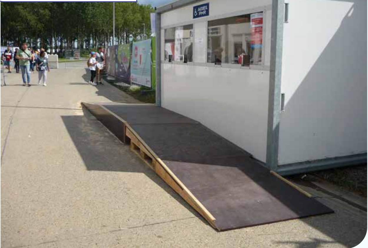
Guichet accessible avec une rampe équipée de chasse-roues
